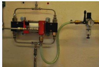
Füllstelle mit Leiste und Booster
