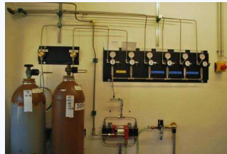
Füllstelle mit Leiste und Booster
